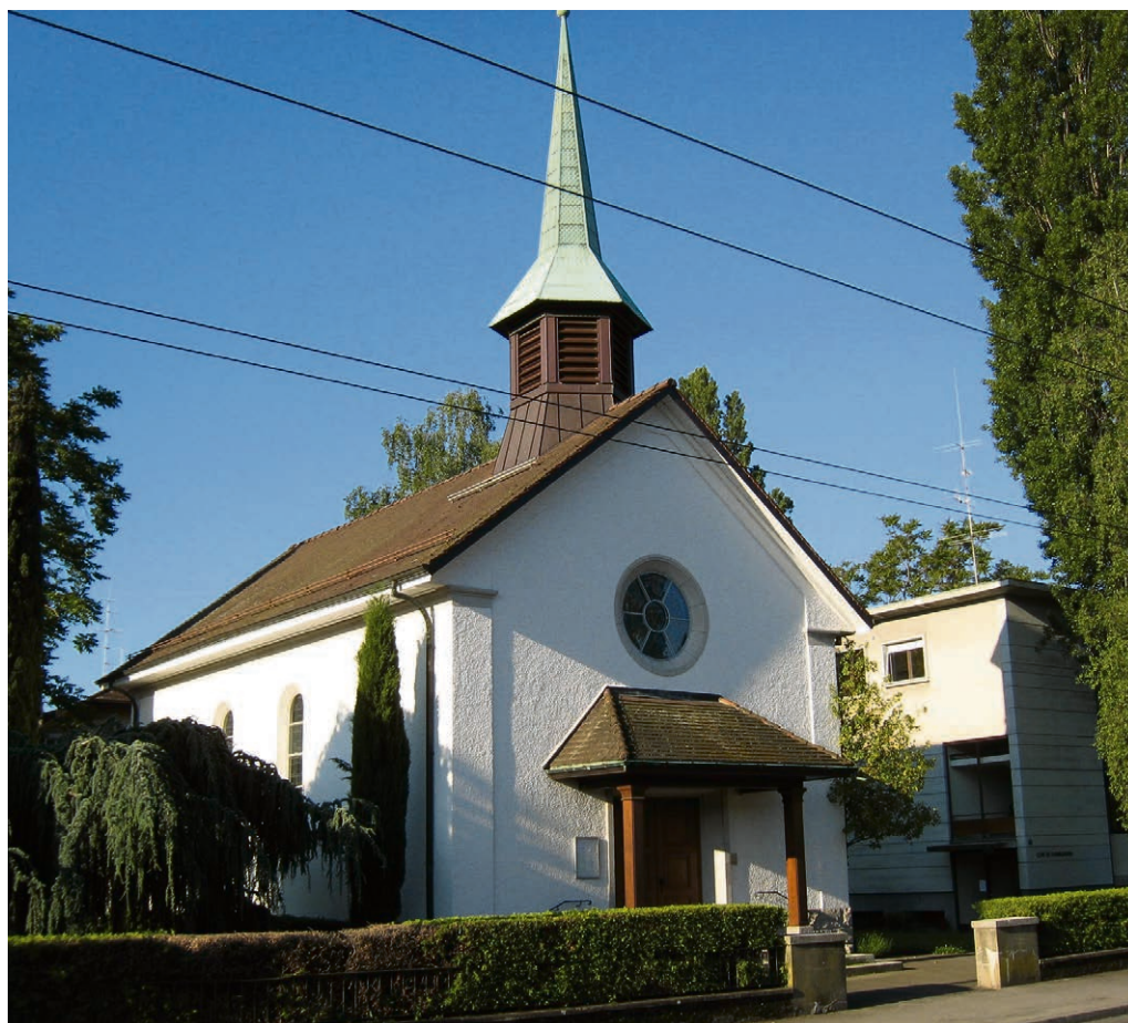
Pully-Paudex l'Eglise de Chamblandes a été construite en 1937.
