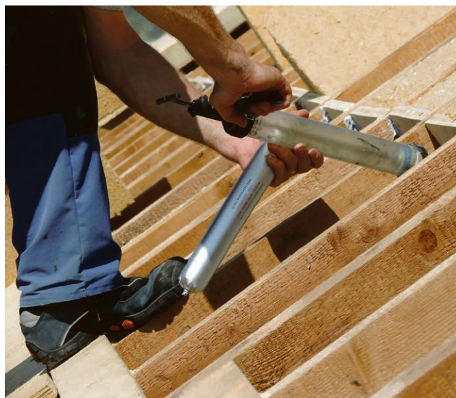
Saint-Saphorin Le centre paroissial est sous toit
