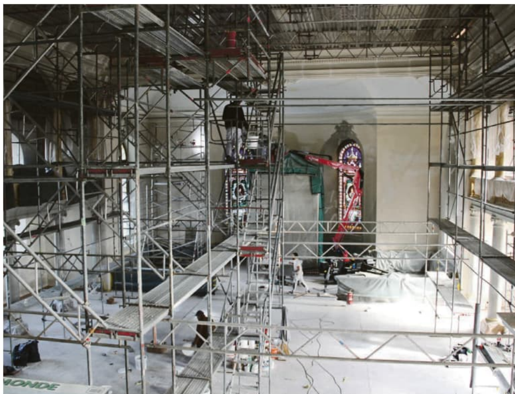
Désamianter, boucher les fissures, mettre à jour le système électrique, peindre... prier, chanter et célébrer. © Christophe Peter.
