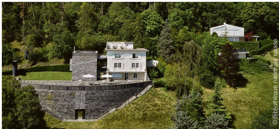
Intégrant la dernière demeure de Dürrenmatt, le centre a réouvert ses portes en mars.
