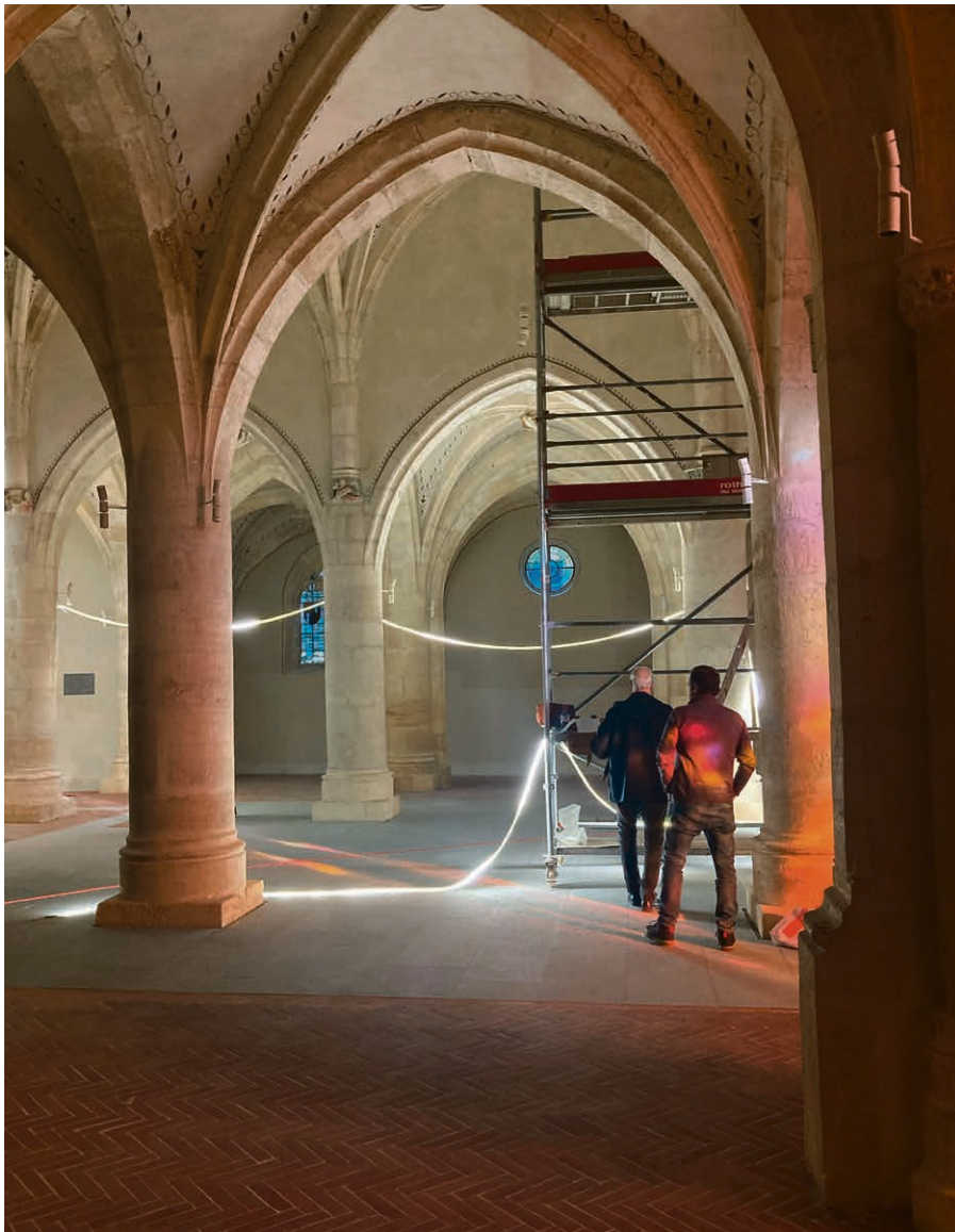
Les derniers échafaudages au temple d'Orbe seront bientôt démontés. Rendez-vous est donné pour sa réouverture lors du culte de Pâques le dimanche 31 mars. © URJ
